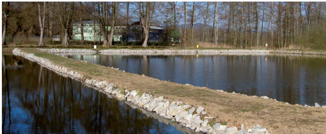
Rybníčky po rekonstrukci.
